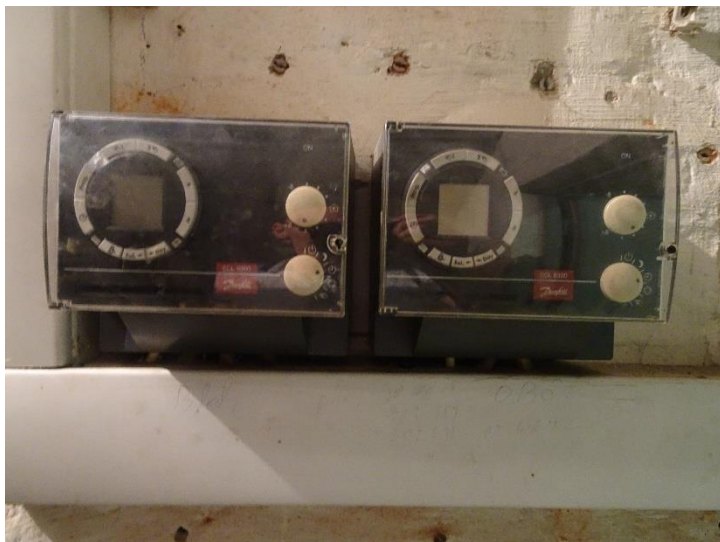
Slika 5.5: Vremenska regulacija Danfoss, ECL 9300.
