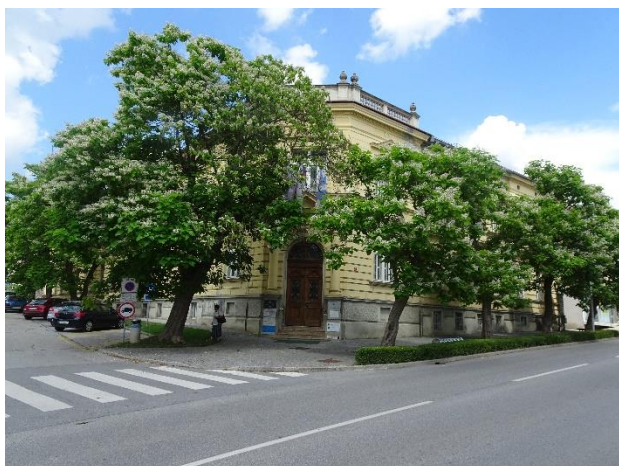
Slika 7.4: JZ pogled na stavbo s ceste.
