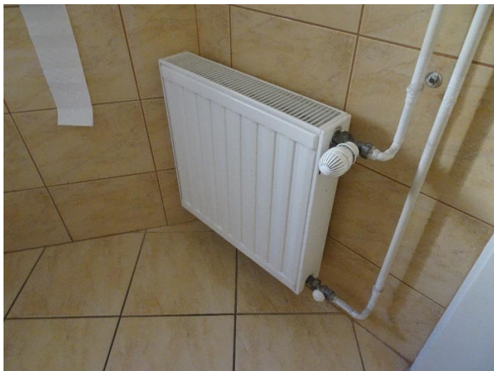
Slika 5.6: Radiator s termostatskim ventilom – ploščni jekleni.
